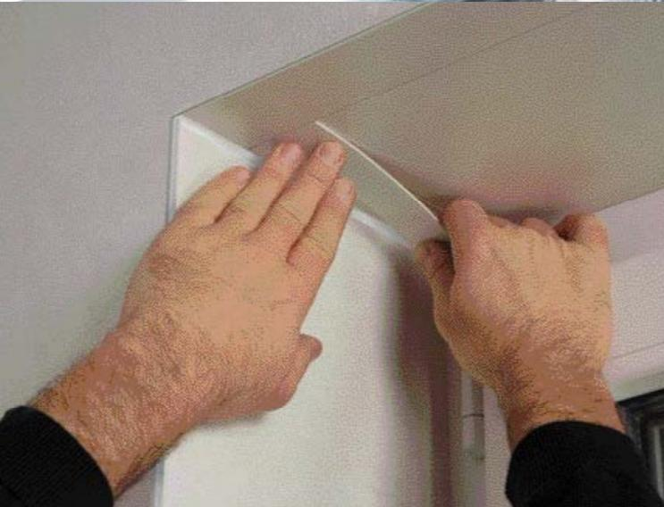
Das Seitenanschlussprofil mit Klippeiste zwischen Mauer und Kastendeckel bildet den seitlichen Abschluss zur Laibung und gleicht auch Maßtoleranzen aus. Eine Klebeleiste verdeckt die Fuge und dichtet sie sicher ab.
